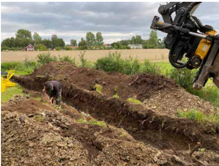
Figur 2. Ett schakt grävs för nedläggning av VA-ledning, strax öster om huset.
