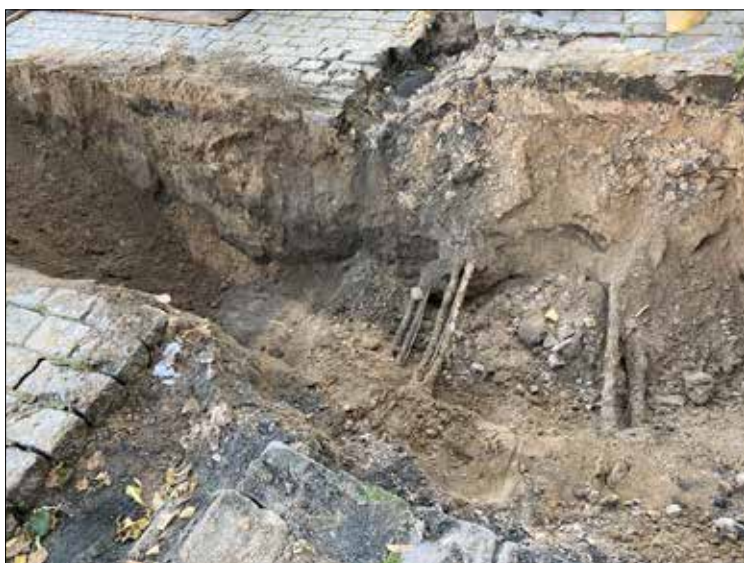
Figur 10. I schaktets södra del, närmast trappen, var området helt stört beroende på tidigare ledningsdragningar. Däremot var schaktets norra del mer intakt där det vek av österut i riktning mot Museigatan. Foto från väst.
