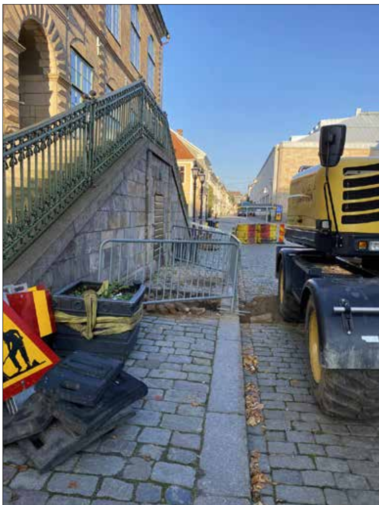
Figur 9. På bilden ses schaktet in under hovrättsbyggnadens trappa. Foto från öst.
