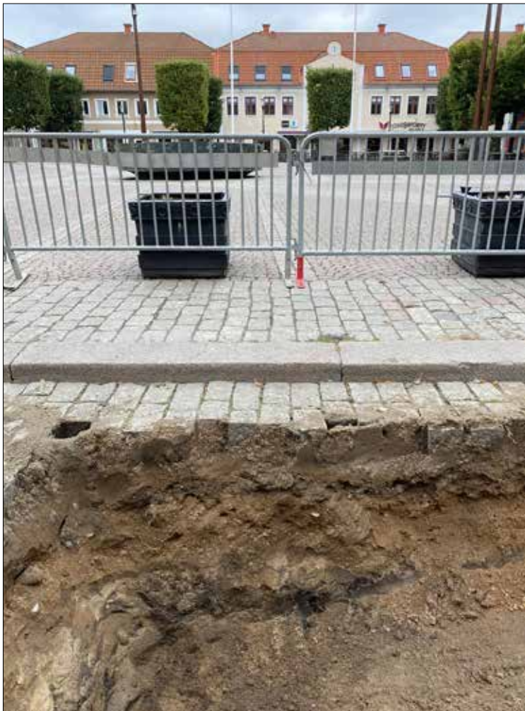
Figur 7. Översikt över den norra schaktväggen i den västligaste delen av fjärrvärmeschaktet. Under fyllnadsmassorna under gatstenen ses det i texten omnämnda lagret i botten av schaktet. I botten av detta påträffades spridda träflis i övergången mot underliggande sand. Foto från syd.
