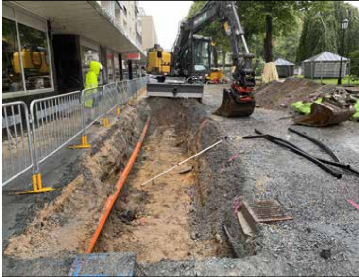
Figur 4. Schaktövervakning i samband med schaktning för det södra planteringsschaktet i Trädgårdsgatan.
