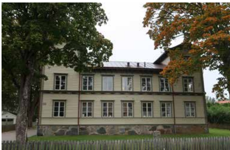
"Slottet" kallas trähuset från 1850-talet på fastigheten Lärkan 7.
