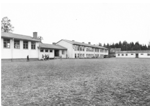
Ekenässjöns skola omkring 1960. Skolbyggnaderna uppfördes 1948 och kom att fungera som örtens skola fram till sent 1970-tal då en ny skola uppfördes i samhällets norra del. Skolbyggnaderna revs i början av 2010-talet för att ge plats åt ett nytt äldreboende. Foto: Vetlanda museum.
