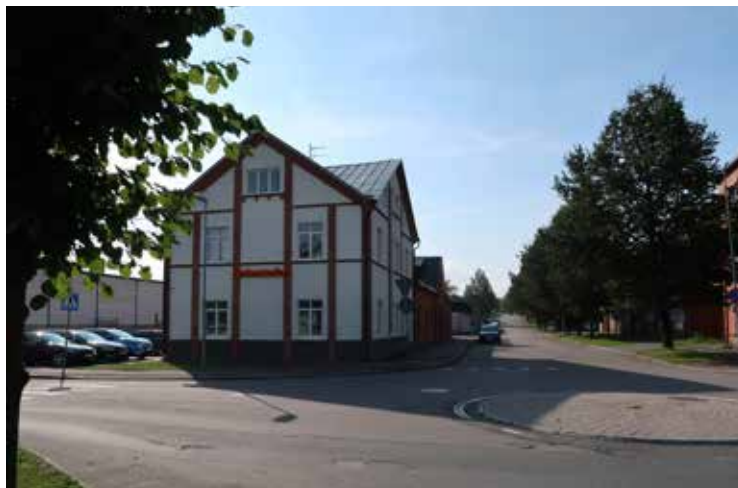
F.d. Vetlanda Mekaniska Verkstads lokal i kvarteret Strutsen. Utmed Magasinsgatan ligger det f.d. gjuteriet.
