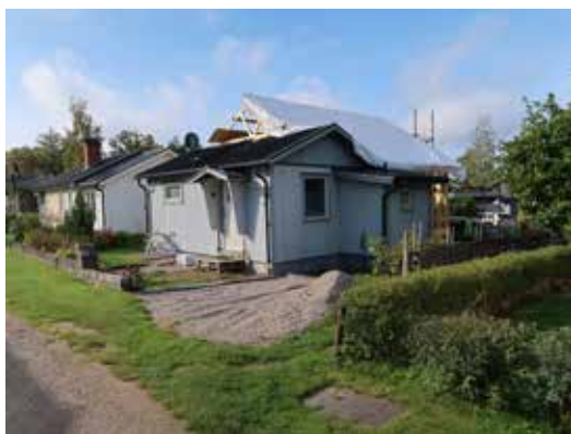
Sportstuga under ombyggnad.
