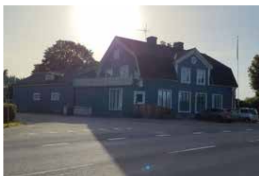
Ombyggd affärslokal utmed väg 31.
