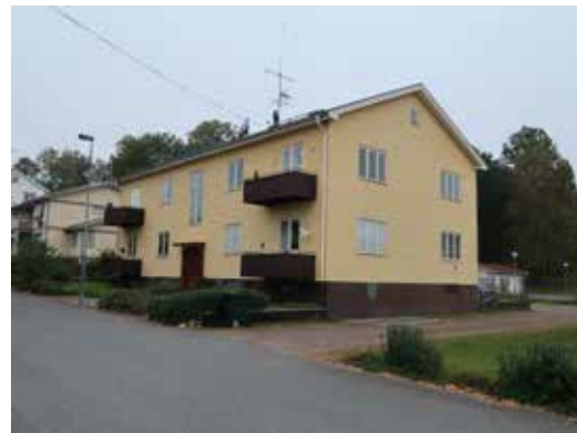
Relativt välbevarat flerfamiljshus vid Ekstigen, kvarteret Diana. Huset har en speciell typ av mönstrad puts.
