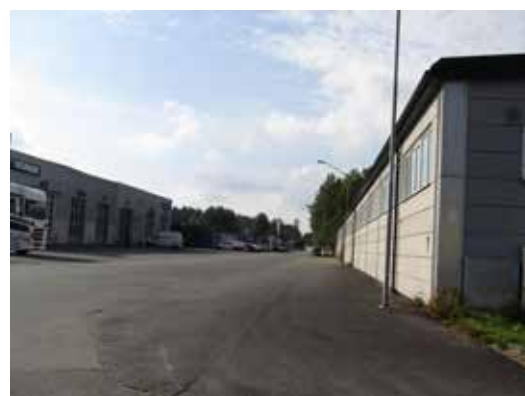
Inom området förekommer industribyggnader från olika tider och i olika skala. På fotona ses en mer småskalig industribebyggelse utmed Östra Nygatan och stora verkstadsbyggnader på Verkstadsgatan.
