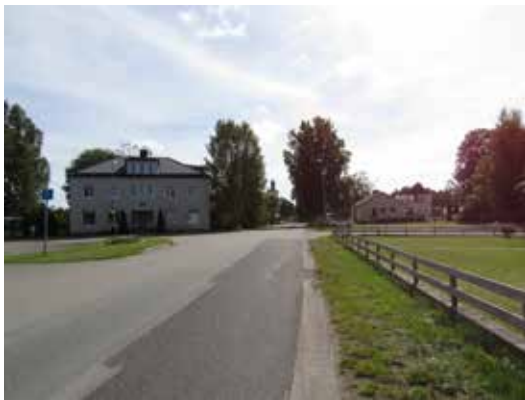
Korsningen Björköbyvägen–Almvägen har hög ålder och utgör ännu ett upplevt centrum i samhället.
