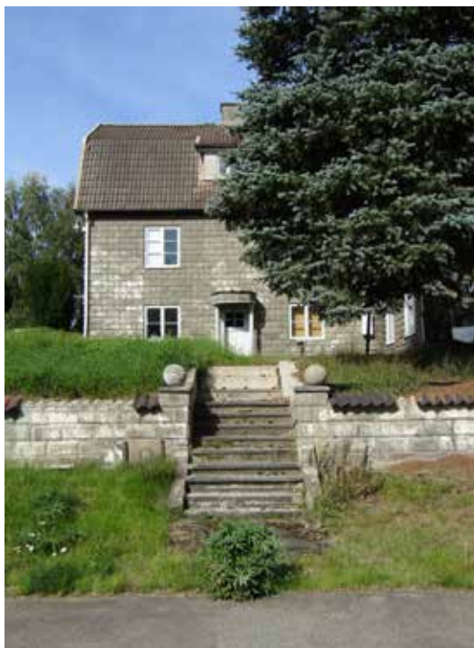
Fabrikör Vilhelm Bäckmans villa i Björköby, uppförd av den betongsten kallad Polstenen som hans företag Vebe tillverkade. Byggnaden och den intilliggande fabriksbyggnaden har såväl byggteknikhistoriska, som samhällshistoriska och personhistoriska värden.
