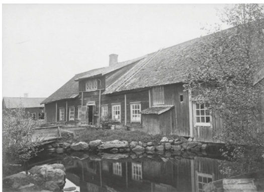
Oljeslageriet intill Emån dokumenterades innan det revs på 1920-talet. Foto: Tekniska museet.
