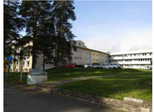
På 1960-talet flyttades stadens lasarett från centrum till Norrgården. Anläggningen har därefter byggts till och byggts om vid flera tillfällen.
