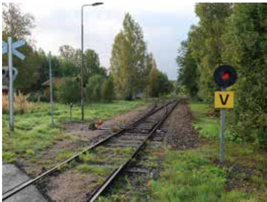
Stationsområdet i Kvillsfors idag. Bakom björken skymtar den barack som ersatte stationshuset.
