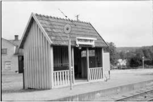
Hållplatsen Holsby by låg intill Storgatans järnvägs-korsning. Mitt emot, på andra sidan spåren, låg en banvaktstuga. Foto: Järnvägmuseet.
