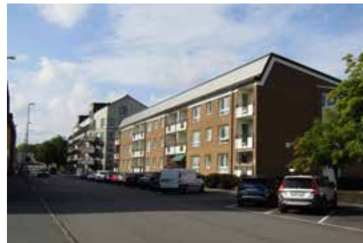
Huset utmed Kyrkogatan inom kvarteret Fasanen uppfördes på 1960-talet och var ett av flera flerbostadshus som uppfördes inom området vid denna tid.
