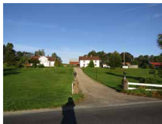
Backegården med mangårdsbyggnad och arrendatorsbostad med tillhörande ekonomibyggnader.
