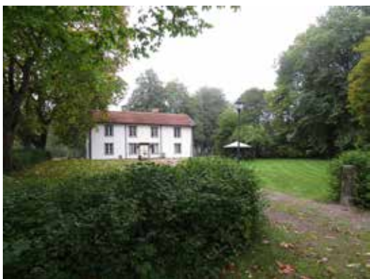
Ett äldre bostadshus är det enda som återstår från den garveriverksamhet som startades i området under 1800-talet.
