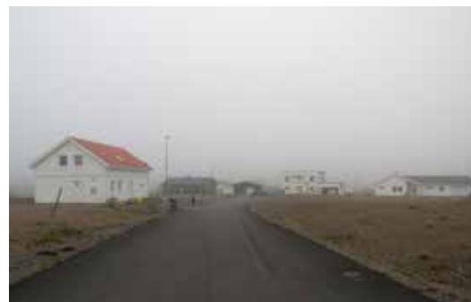
Delar av området är ännu under uppbyggnad.
