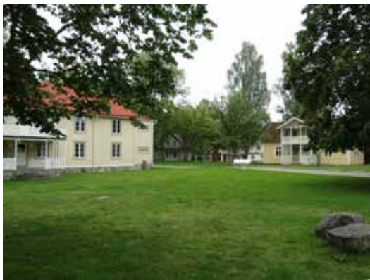
I slutet av 1700-talet anlades en hälsobrunn i nuvarande Holsbybrunn. Anläggningen var i drift med möjlighet till bad och brunnsdrickning ända fram till mitten av 1900-talet. Området med brunn och byggnader från 1800-tal och tidigt 1900-tal är av stort intresse som länets enda bevarade brunnsanläggning.
