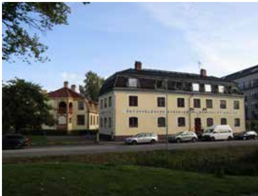
Svedbomska villan är byggnadsminnesförklarad, men även den intilliggande verkstadsbyggnaden har höga kulturhistoriska värden.
