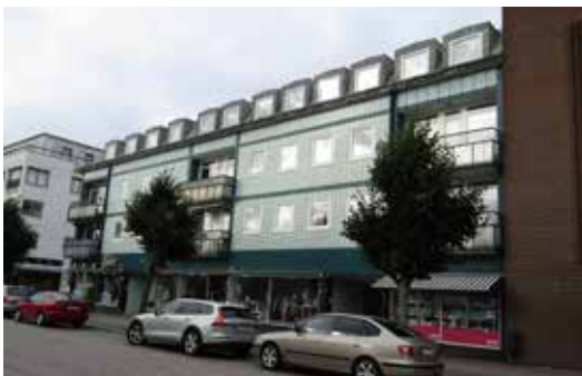
Ett tidstypiskt affärs- och bostadshus med klinker- och kakelklädd fasad från 1950-talet utmed Vitalagatan.
