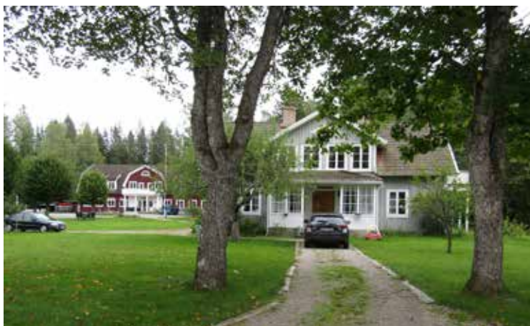
Brunnsvillan uppfördes 1899 och inrymde läkarmottagning och -bostad. Till vänster skimtar badhuset som uppfördes 1926.
