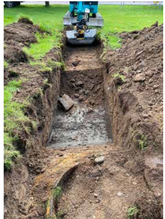
Figur 9. Ytterligare en bild på skräp i fyllningen och blåleran i botten i ett av schakten.
