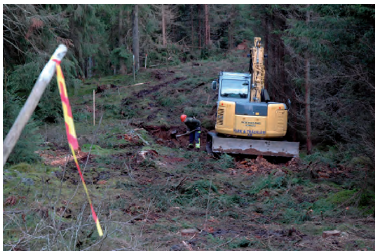
FIGUR 3.2. Grävning av långprofil med maskin, Kansjö-grävningen JLM dnr 304/2011.
