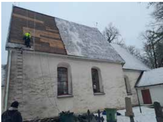
Arbetet med rivning av spåntäckningen har inletts.
