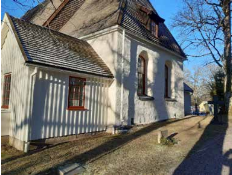
Östra fasaden i januari 2024 sedan ställningen är nedmonterad. Foto: Karin Arvidsson.
