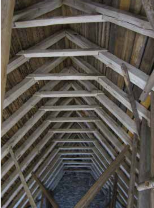
Hanbjälkarnas samtliga knutar sågs över. Instabila knutar justerades och skadade dymlingar byttes ut.
