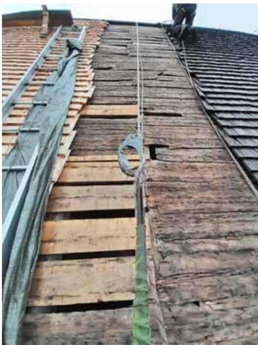
Underlagstaket består av bräder av olika ålder. De äldsta är kluvna och huggna, de yngre sågade. Foto: Hälsinge takspån.
