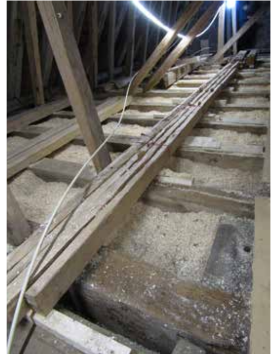
Vindsbjälklaget isolerades med spån. På bilden ses även fyra ekbjälkar som kluvits och sprätthuggs i samband med projektet.
