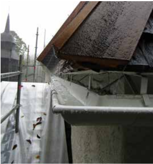
Kortet försågs med nya, bredare hängrännor. Nya hängrännekrokar tillverkade med de tidigare som förlaga.
