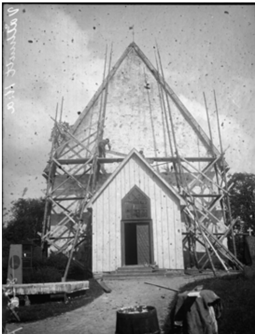
Kyrkans västra fasad fotograferad 1927. Ställningen tyder på att det skulle utföras någon typ av åtgärder. Notera vapenhusets fönster. Riksantikvarieämbetet
