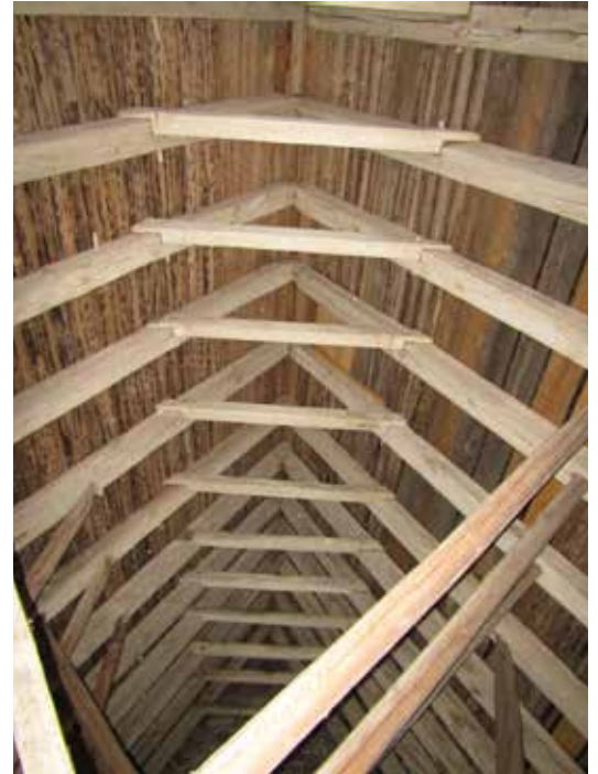
Hanbjälkarnas knutar i högbenen behövde ses över. Flera knutar var glappa och flera dymplingar i knutarna var avbrutna.
