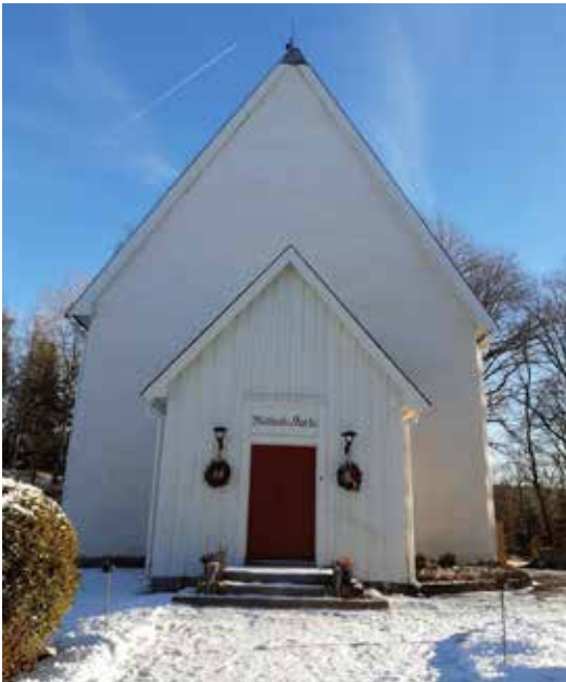
Vapenhusens träfasader ommålades med linoljefärg i en kulör lika tidigare. Källarnedgångens plåtinklädnad målades också med linoljefärg.
