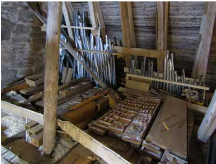
Vindsbjälklaget isolerades med spån. På bilden ses även fyra ekbjälkar som kluvits och sprätthuggs i samband med projektet.
