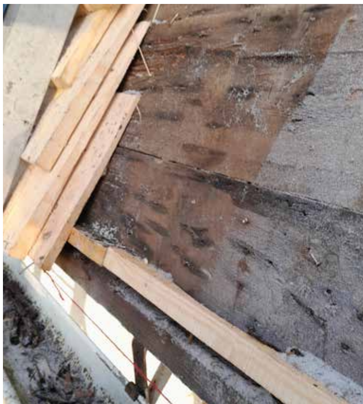
Underlagstaket består av bräder av olika ålder. De äldsta är kluvna och huggna, de yngre sågade. Foto: Hälsinge takspån.
