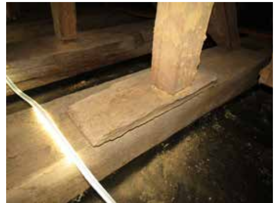
Här och var på vinden finns äldre byggnadsdelar som återanvänts vid lagningar och som upplag.
