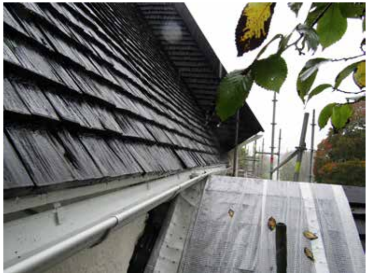
Vid korets norra takfall monterades en hängränna i takets fulla längd, vilken "knäcktes" över sakristiansnock.
