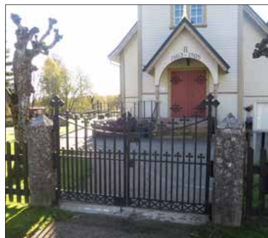
Huvudingången mitt för kyrkans entré åt norr har gjutjärnsgrind med nygotiska kors och granitstolpar.
