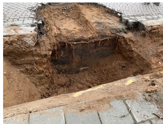
Figur 5. Ena väggen till skyddsrummet som är beläget under torget och som påträffades i schakt 1.
