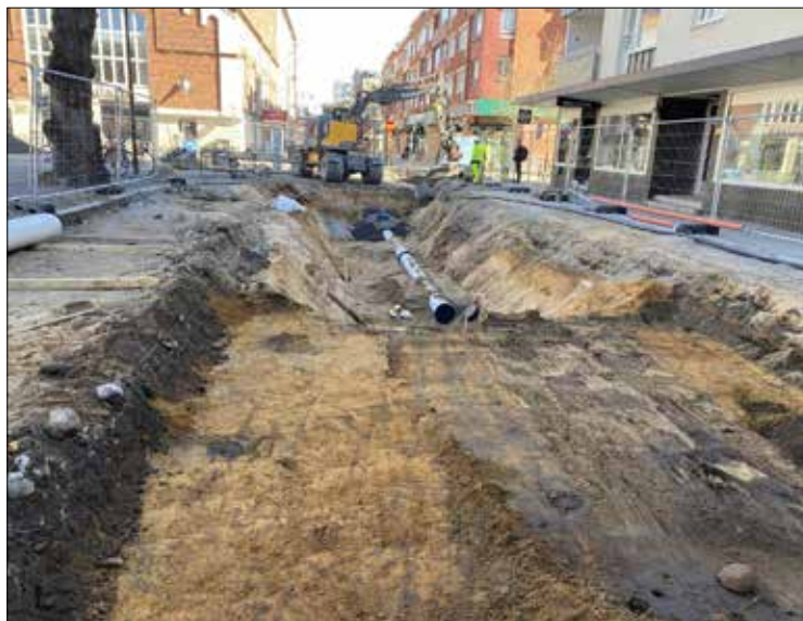
Figur 85. Rester efter årderspår i Trädgårdsgatan sedan det ovanliggande lager 10 grävts bort. Årderspårerna avtecknar sig som bruna streck mot den gulaktiga sanden=undergrunden. De två groparna till vänster i bilden är återstoden av ett par grävda provgropar i lager 10 (se även Figur 42 och Figur 43).
