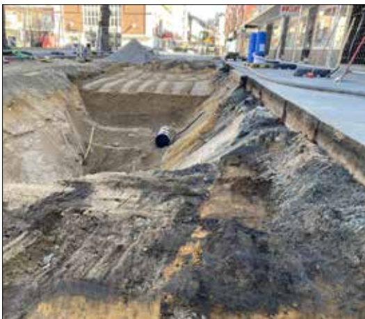
Figur 54. Återstoden av nedgrävningen A22 intill den östra schaktkanten.
