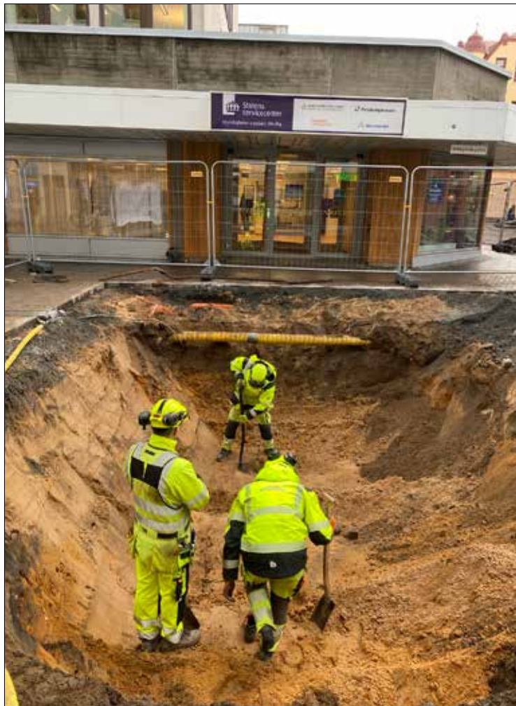
Figur 27. Djupgrävning i Trädgårdsgatan ner till nivån för de rör som skulle bytas ut.
