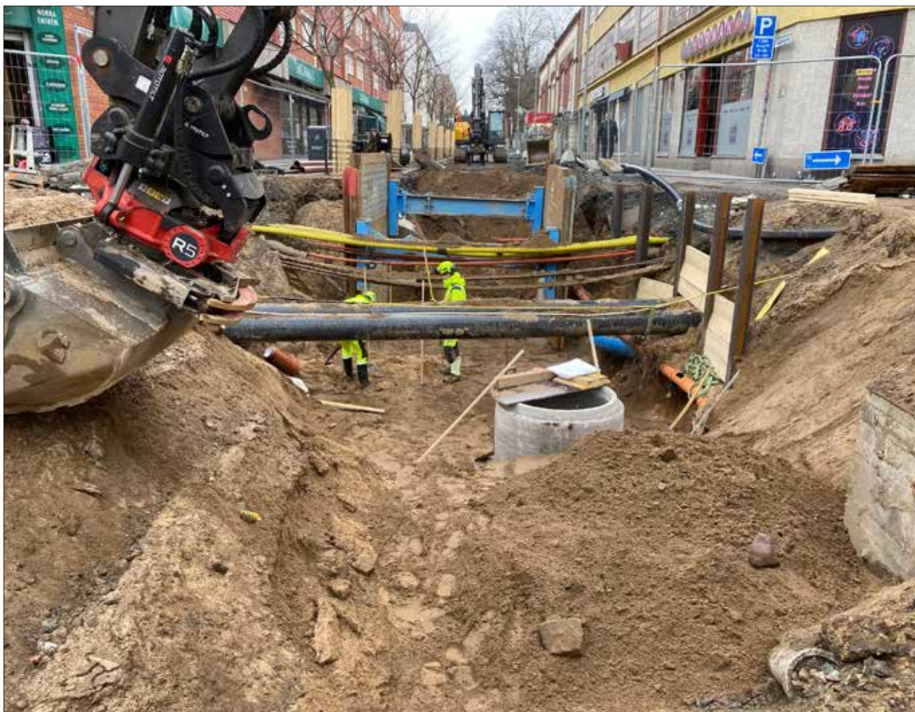
Figur 30. Utfyllnadsarbeten i korsningen Trädgårdsgatan/Skolgatan efter avslutad schaktning. I bakgrunden skymtar den blå schaktlådan som sattes ner i korsningen Skolgatan/Trädgårdsgatan.
