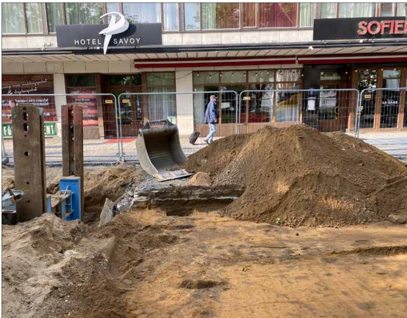
Figur 71. Översiktsfoto som visar läget för det delvis bevarade diket/rännan A29 i relation till dagens bebyggelse. Den bevarade delen av anläggningen ses närmast betongplinten med profil under denna.
