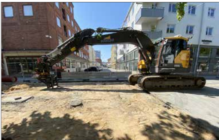
Figur 74. Schaktet i korsningen Brunnsgatan/Fabriksgatan med de många brunnarna.
