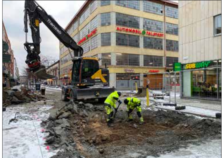
Figur 18. Påbörjad maskinsschaktning i undersökningsområdets nordligaste del i Trädgårdsgatan.
