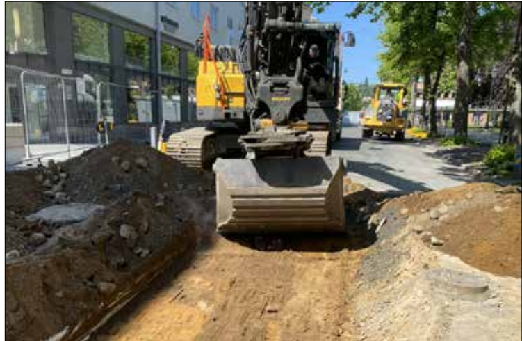
Figur 75. Intakt yta mellan ett par brunnar med undergrunden och spår efter stensyllen.
