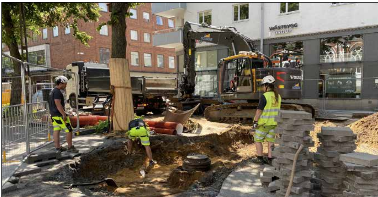
Figur 80. Schakt i trottoaren längs med norra sidan av Brunnsgatan. Området var mycket stört på grund av en tidigare brunn.
