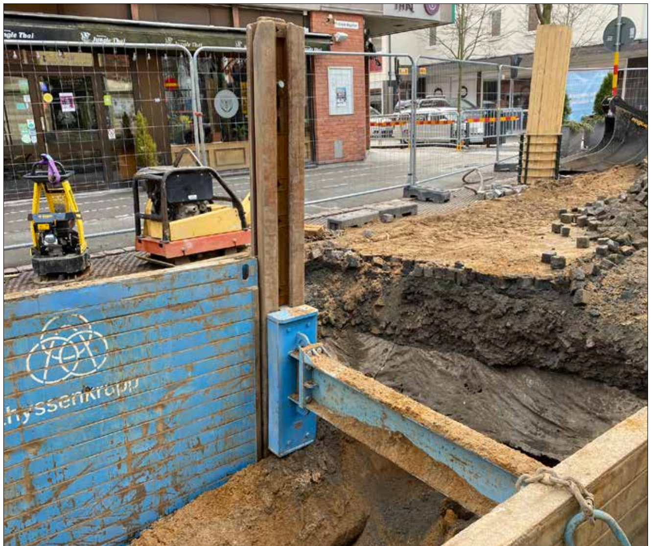
Figur 31. Schaktlåda och påbörjad nedgrävning för nästa "lådnedgrävning" i Trädgårdsgatan just norr om Nygatan. Under de kvarliggande gatstenarna ses det tjocka, påförda anläggningslagret som präglat hela gatusträckningen i Trädgårdsgatan norr om Nygatan.
