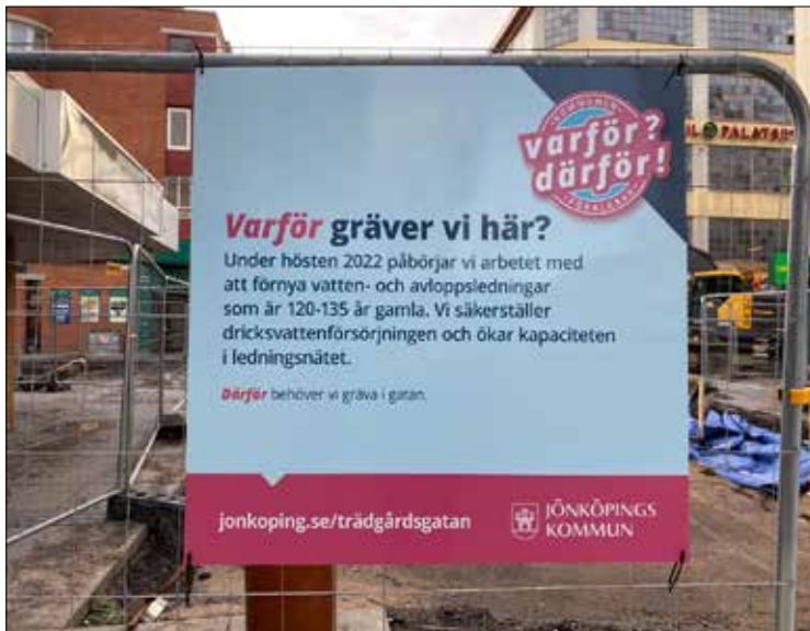
Figur 2. Jönköpings kommun informerar allmänheten om anledningen till markarbetena i gatorna i centrala Jönköping.
