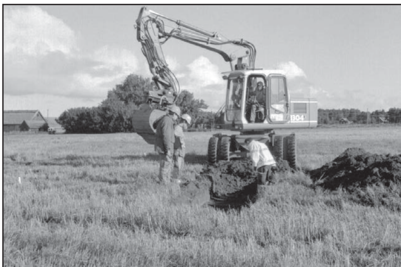
Figur 3. Påbörjad schaktning inom området för den eventuella vallgraven. Foto från söder, Kristina Jansson. Jlm neg. nr. 03/3:342.
