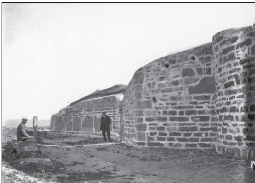
Figur 8. Visingsöborg efter restaureringen 1907. Det bortgrävda området norr om borgen har grävts ner till nivån för det första skiftet i grundmuren, och till vänster i bilden ligger troligtvis överblivna stenar från originalmuren. Foto: Algot Friberg från västnordväst. Jlm neg. nr Å.II.25 och reg. nr. 95/1:2145.
